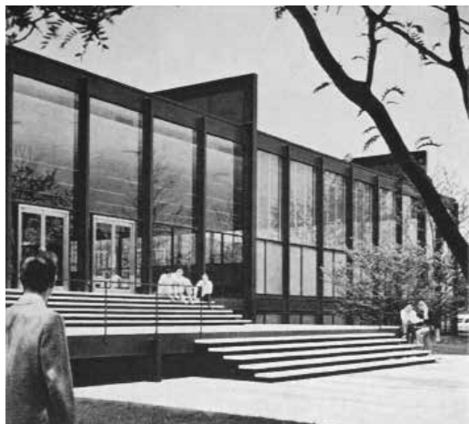
این شیشه‌های مات در کل ساختمان به کار نرفته. میس، بیرون ساختمان، چهار قاب خمشی بزرگ فولادی، به فاصله ۱۸/۲۸ متر از هم، کار گذاشته تا سقف را نگه دارند.
