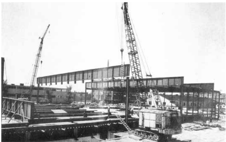
این شیشه‌های مات در کل ساختمان به کار نرفته. میس، بیرون ساختمان، چهار قاب خمشی بزرگ فولادی، به فاصله ۱۸/۲۸ متر از هم، کار گذاشته تا سقف را نگه دارند.
